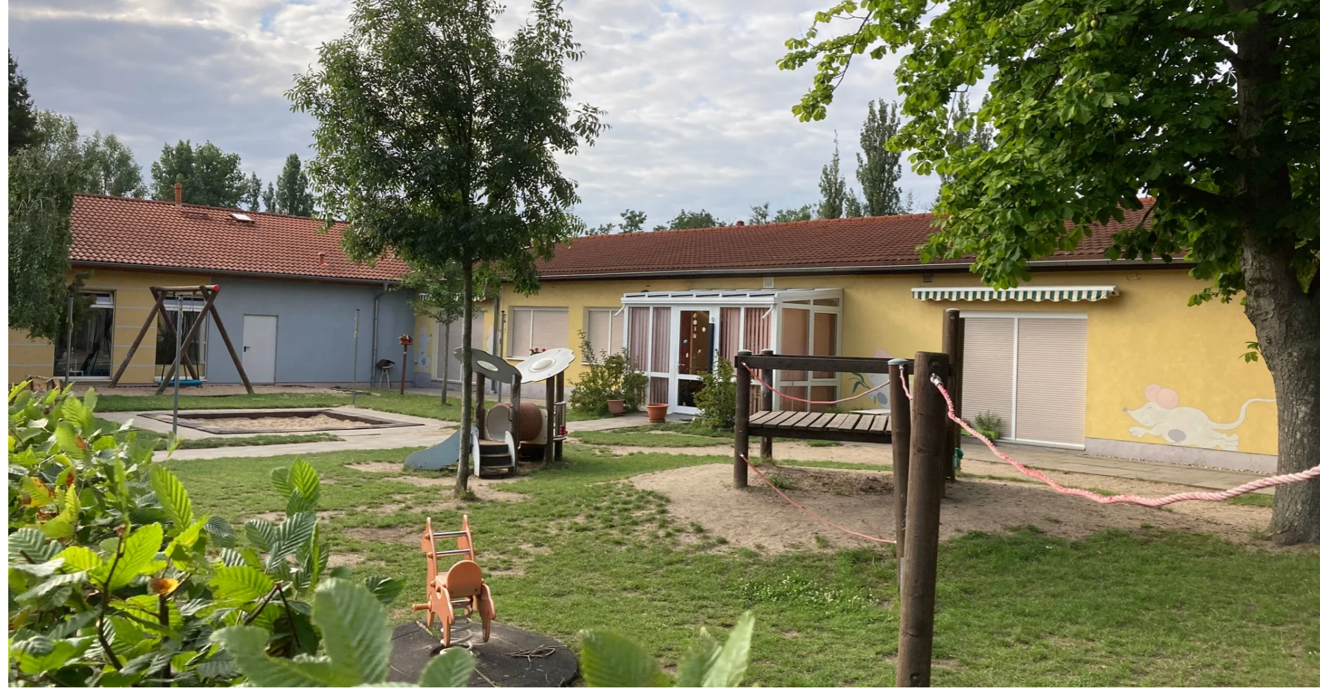
Die Kita in Lochau soll durch einen Neubau ersetzt werden. Der soll am ehemaligen Garagenkomplex zwischen Sportplatz und Seniorenheim entstehen. (Foto: Laura Nobel)
